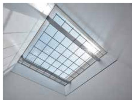
Mit einer geprüften Fallhöhe von 2,40 m und einer Maschenweite von 100 mm entspricht das RSM dabei europäischen Standards. Es ist zudem nach Einbau des Aufsetzkranzes zertifiziert durchsturzsicher nach GS-BAU-18:05-2020 und erfüllt die Primäranforderung der Arbeitsstättenrichtlinie ASR A2.1.
