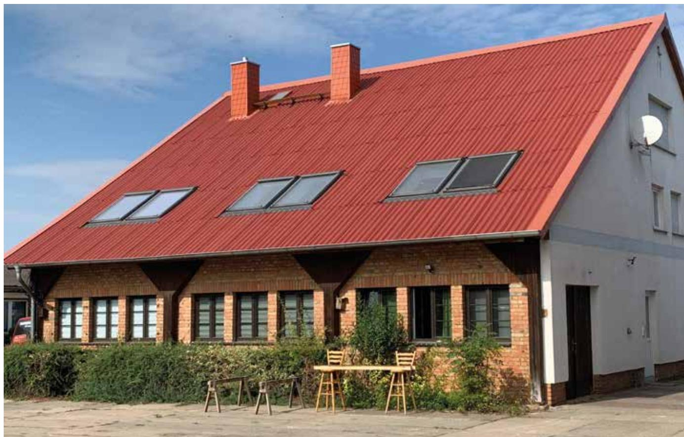
Onduline Duro SX 35 ist eine neue Bitumenplatte im Trapezprofil-Design mit 3,5 mm Materialstärke, die der EN 534 Kategorie S entspricht. Die Bitumenplatten mit Kunstharzthermoverhärtung und Farbeintränkung bieten hervorragende Stabilität und Haltbarkeit, für Anwendungen als Dach- und Wandplatte.
