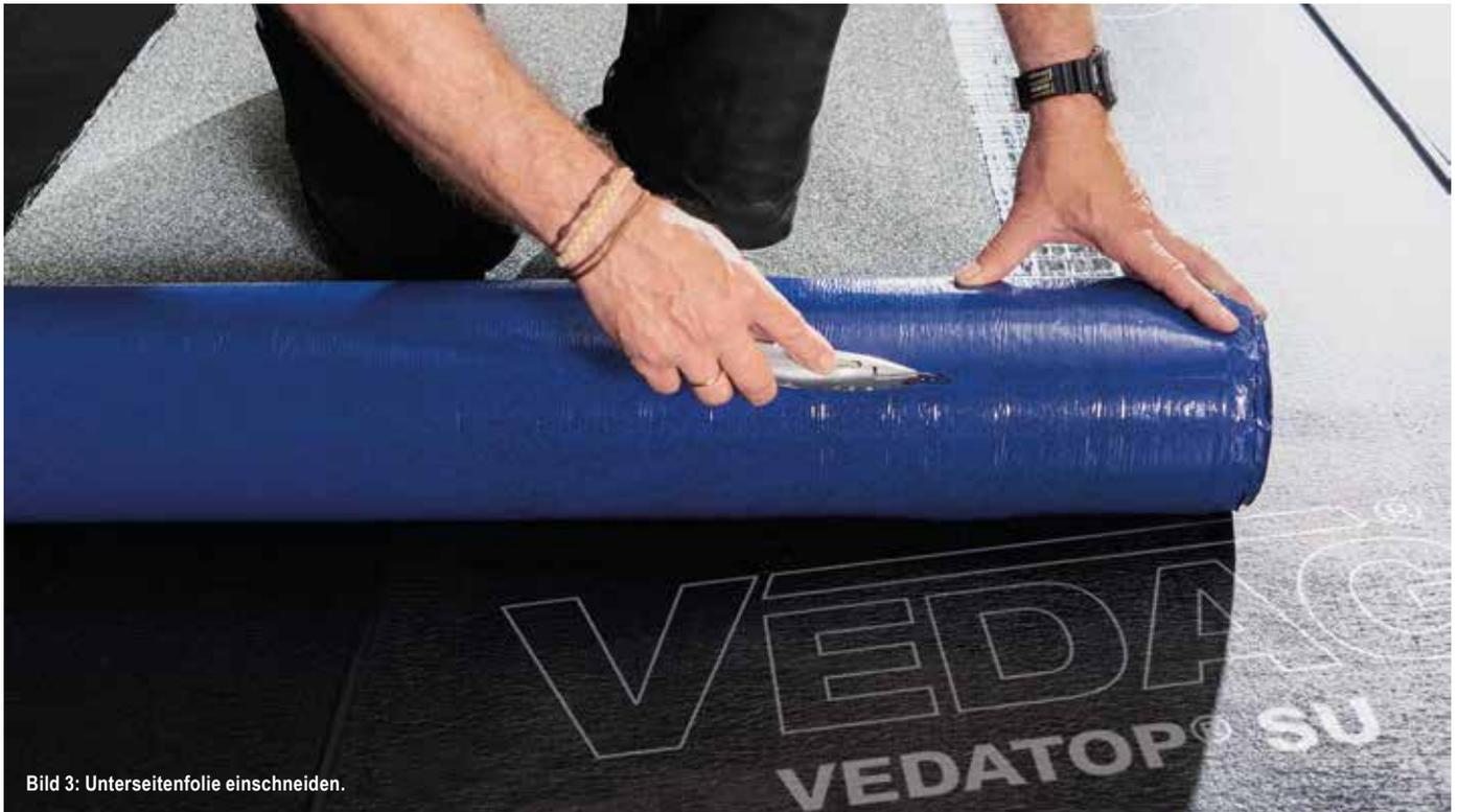
**Bild 3:** Unterseitenfolie einschneiden.
