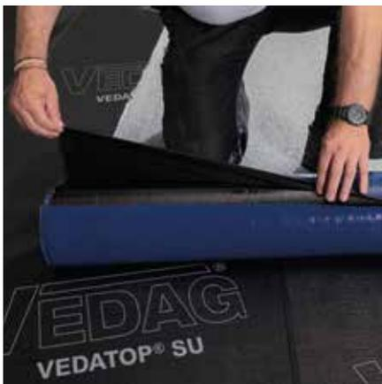
**Bild 4:** Unterseitenfolie lösen und umschlagen.
