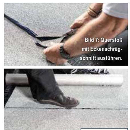
**Bild 7:** Querstoß mit Eckenschrägschnitt ausführen.
