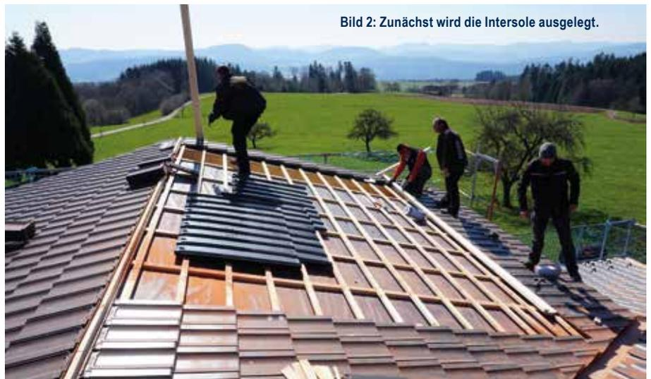
**Bild 2:** Zunächst wird die Intersole ausgelegt.
