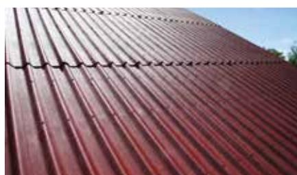
erfüllen hohe mechanische sowie physikalische Eigenschaften und haben die wichtigen Tests für Wasserdichtigkeit nach Alterung bestanden, wobei die Reißfestigkeit nach Alterung >150 N beträgt.
