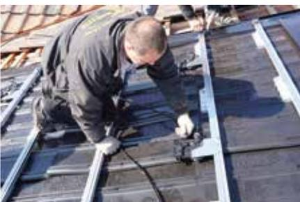
**Bild 8:** Das AC-Kabel wird eingeklipst.
