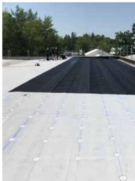
Die Befestigungselemente werden in den vorhandenen Dachaufbau geschraubt. Die HERTALAN® EPDM-Plane wird dann direkt über der PVC-Altabdichtung verlegt.
