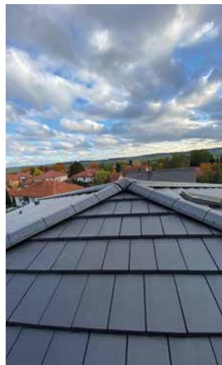
Ergoldsbacher Level RS<sup>®</sup>: Der neue Glattziegel für flach geneigte Dächer ab 10 °.
