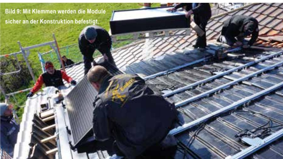
**Bild 9:** Mit Klemmen werden die Module sicher an der Konstruktion befestigt.
