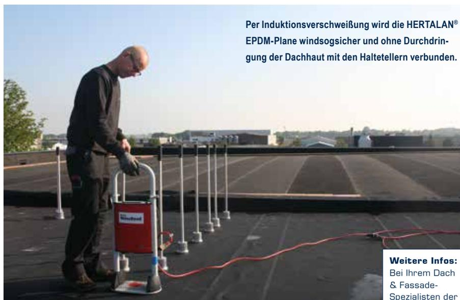
Per Induktionsverschweißung wird die HERTALAN® EPDM-Plane windsogsicher und ohne Durchdringung der Dachhaut mit den Haltetellern verbunden.
