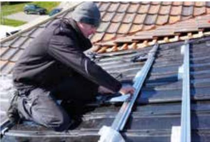
**Bild 7:** Dann werden die Mikro-Wechselrichter montiert.
