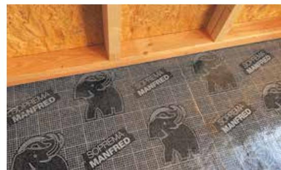
Weil die Bahn sich auch flammlos verarbeiten lässt, ist sie eine ideale Ergänzung für den Holzbau, zum Beispiel auf der Bodenplatte und als luftdichter Randanschluss zur Schwelle im Holzbau.
