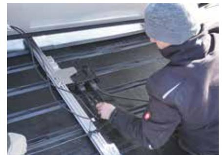
**Bild 10:** Die PV-Module werden an den Mikro-Wechselrichter angeschlossen.
