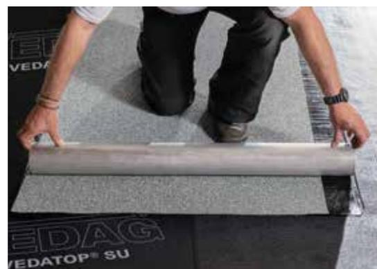
**Bild 1:** Turbo TO im Lagerversatz zur Unterlage ausrichten, straff auf den Wickelkern aufrollen und bis ca. zur Bahnenmitte zurückrollen.
