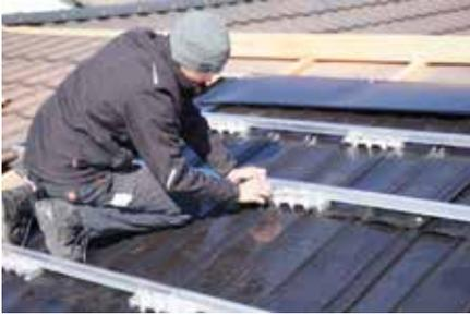
**Bild 6:** Die Schienen werden montiert und ausgerichtet.
