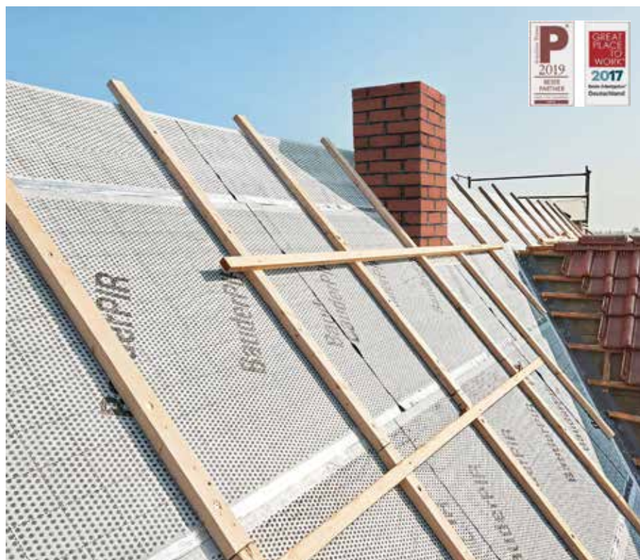
Beispiel 1: BauderPIR „+0“ oder BauderPIR „1:1“ Teildämmung zwischen den Sparren mit waagrecht verlegter Luftdichter Schicht
