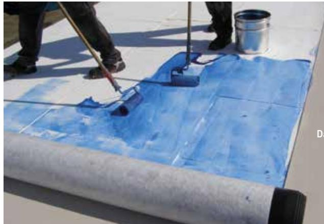
Verkleben der Flachdachabdichtungsbahnen Sarnafil TG 76-18 Felt PS: Mit dem Lammfellroller wird der PU-Klebstoff Sarnacol 2142 S flächig verteilt. Nach dem Ablüften können die Abdichtungsbahnen von den Dachdeckern direkt in den Klebstoff eingerollt und mit einer Walze angepresst werden.
