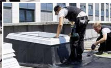
Der Systemrahmen des Flachdachfensters lässt sich schnell und einfach auf seine Unterkonstruktion aufsetzen.
