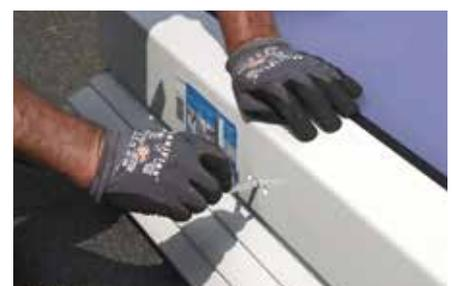
Schnelles und sicheres Verriegeln der Kuppel mit Vierkantschlüssel.
