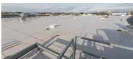
Die mit Sarnafil-Kunststoffbahnen sanierte Dachfläche des METRO-Großmarkts in Regensburg.
