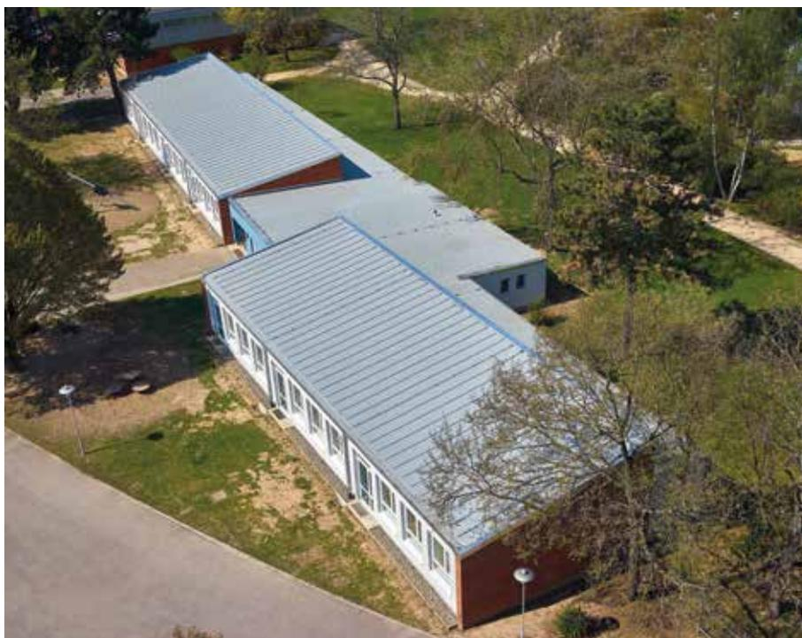
Als dauerhaft UV-beständige Premiumdachbahn ist Rhepanol® hfk in Bahnenbreiten von 0,50 m, 1,00 m und 1,50 m erhältlich. Ergänzt wird die PIB-Premiumdachbahn durch ein umfangreiches Zubehörangebot. Es beinhaltet alle notwendigen Formteile für eine fachgerechte Ausbildung von Details, Anschlüssen, Durchdringungen oder Dachrandabschlüssen.
