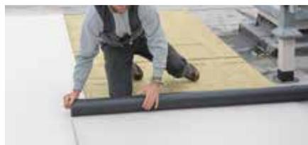
Die Sarnafil-Kunststoffbahnen werden auf der Steinwolle-Wärmedämmung ausgerollt.
