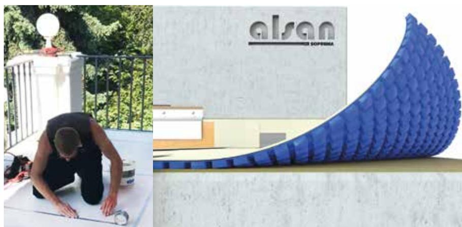
Nach der Untergrundvorbereitung wird die Grundierung in Streifen appliziert, so dass jeweils grundierete und nicht grundierete Flächen nebeneinanderliegen. Darüber wird die verlegefertige Abdichtungsmatte geklebt. Wasserdampf und damit entstehender Dampfdruck können an den nicht grundierten Streifen aus dem Untergrund entweichen und werden über die Noppenstruktur der Matte zu den Seiten abgeleitet.
