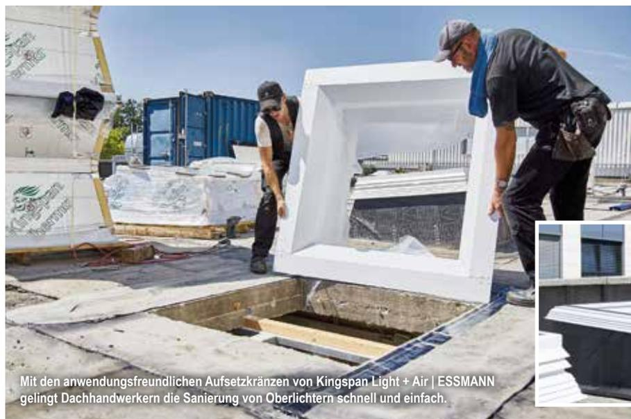
Mit den anwendungsfreundlichen Aufsetzkränzen von Kingspan Light + Air | ESSMANN gelingt Dachhandwerkern die Sanierung von Oberlichtern schnell und einfach.
