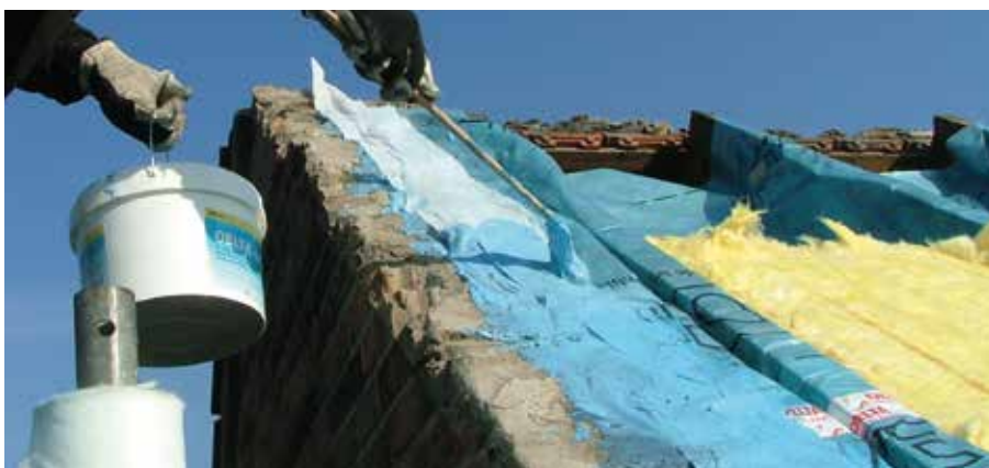
Abb. 5: Luftdichter Anschluss am Giebelmauerwerk mit einer flüssigen Funktionsbeschichtung.
