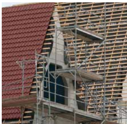
Dachneigung über 65°, Sanierung Kirche Stralsund
