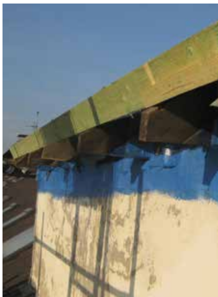
Abb. 3: Einfassung der Sparren mit der Luft- und Dampfsperre und einer flüssigen Funktionsbeschichtung.
