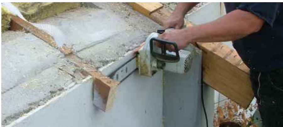
Abb 4: Minimierung der Durchdringungen durch Abschneiden der Sparrenköpfe
