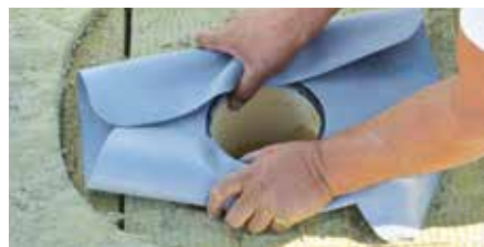
Topf-in-Topf-Sanierung: Einsetzen des SitaSani® 160 DSS mit Wunschanschlussmanschette.
