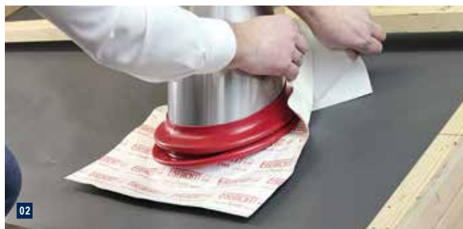
02 Luftdichtungsmanschette für die sichere Abdichtung von Abgasrohren bis 250° C.
