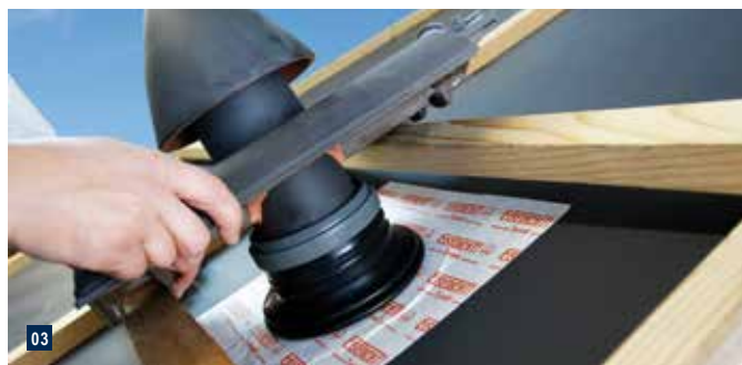
03 Luftdichte Rohrweiterführung durch die Dachbahnebene, dank integriertem Formstück.
