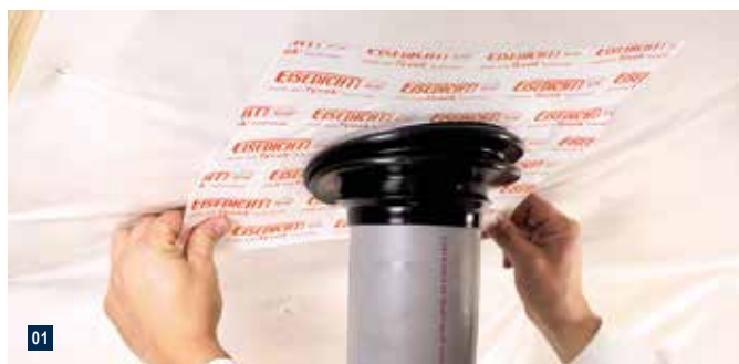
01 Mit den selbstklebenden Dichtmanschetten können auch Durchdringungen bei Steildächern einfach abgedichtet werden.
