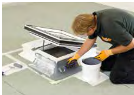
BauderLIQUITEC – das Flüssigkunststoff-Abdichtungssystem für komplexere Durchdringungen und Details auf dem Flachdach.
