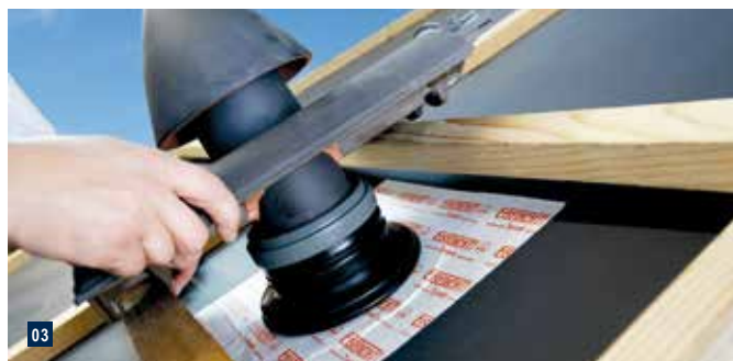
Luftdichte Rohrweiterführung durch die Dachbahnebene, dank integriertem Formstück.
