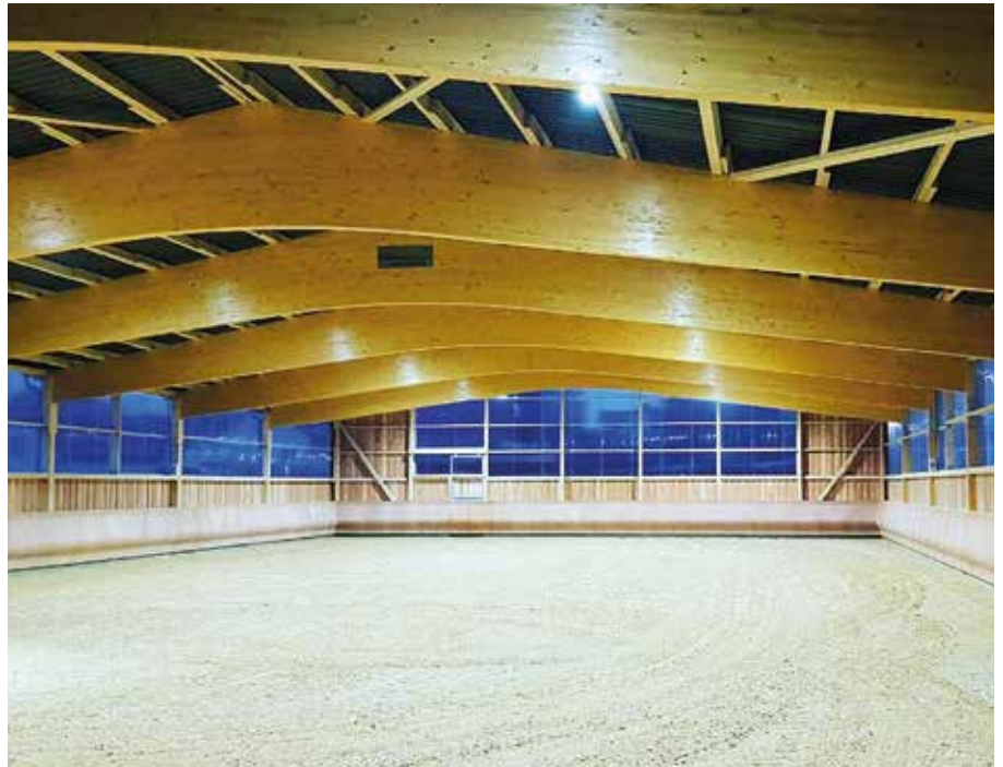
Auf 16 Stützen ruhen acht Satteldachträger (Brettschichtholzbinder) mit angehobenem Untergurt und einer Spannweite von über 21 m. Für die Montage der CEMBRIT Wellplatten wurde ein Sekundärtragwerk bestehend aus Koppelpfetten im Abstand von 1,15 m erstellt.
