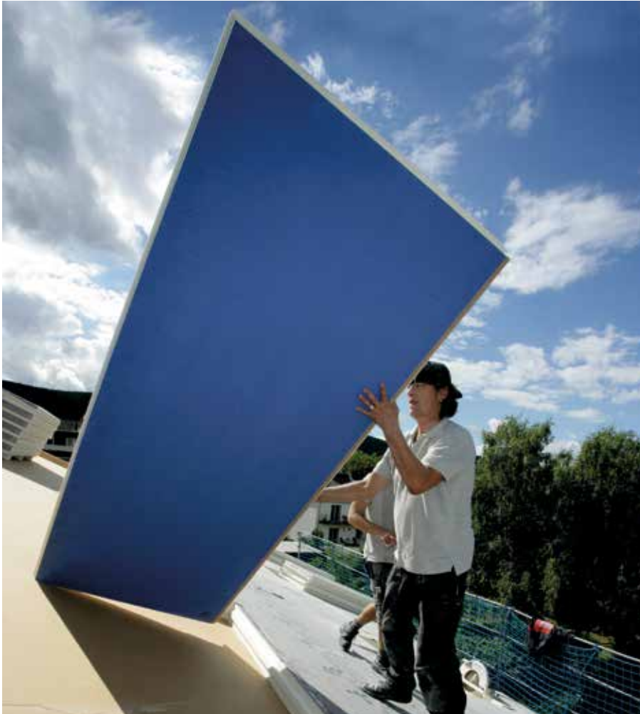
Ein großer Einsatzschwerpunkt für PU-Dämmstoffe ist das geneigte Dach. (Foto: puren)
