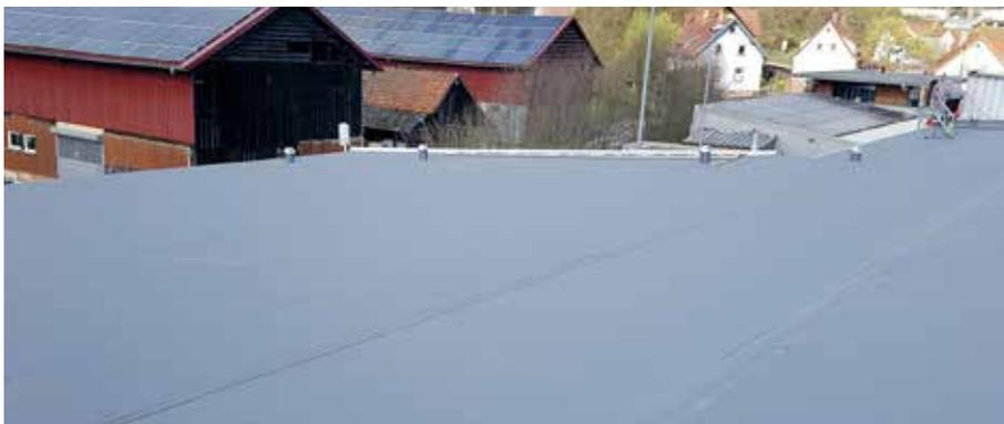
Jeder kennt die geläufigen 3 Methoden der Lagesicherung: diese sind die mechanische Befestigung, der verklebte Aufbau und die Sicherung durch Auflast. Protan hat bereits vor 20 Jahren eine 4. Art der Lagesicherung sehr erfolgreich in Europa eingeführt, das einzigartige Vakuumdachsystem. Dabei wird die Lagesicherung durch den Unterdruck bei Winde erreicht.
