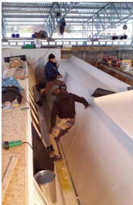
Die extrem beengten Platzverhältnisse erschwerten die Abdichtungsarbeiten.
