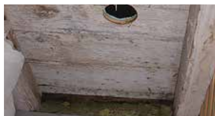
Bereits einige Wochen nach dem Einbau der Lüftungselemente zeigt sich das Holz völlig trocken und das Schimmelpilzwachstum ist gestoppt.
