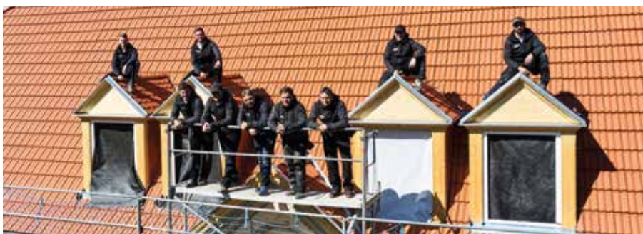
Zimmermeister Volker Hanisch (Mitte) und sein Team haben ganze Arbeit geleistet. In wenigen Monaten konnten sie das sehr baufällige Dach komplett sanieren.
