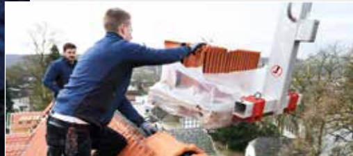
Steil und hoch: Für die anschließende Eindeckung wurden die Firstziegel mit Hilfe eines Krans auf das Dach gebracht.
