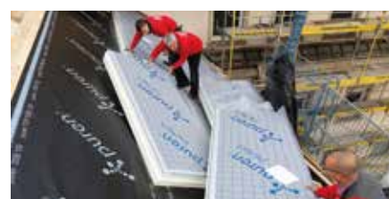
Verlegung der Steildachdämmung.
