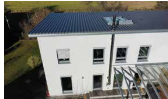
Das Ergebnis kann sich sehen lassen: Rund 171 m² wurden mit Systemzubehör und Dachziegeln von Creaton eingedeckt. Unter dem 7° Dach herrscht nach vier Wochen Sanierungsarbeiten jetzt Ruhe.
