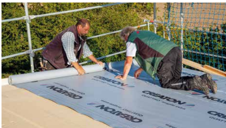
Verlegen der Unterdachbahn Creaton Quattro longlife extra auf den bestehenden Unterdeckplatten.
