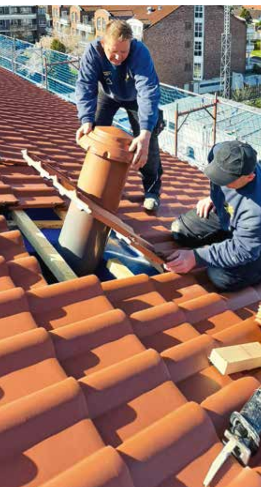
Der Wrasenlüfter von FLECK – hier in der Größe DN 250 – wird einfach in die vorhandene Dacheindeckung eingesetzt.
