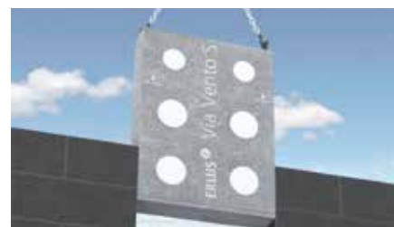
Via Vento S Fertigfuß – Spart Zeit: Der vorgefertigte Fuß für den Wandanschluss wird einfach mit dem Kran in die Wandaussparung gesetzt.
