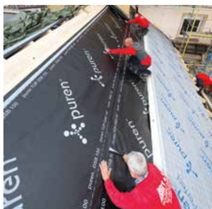
Vollflächige Verlegung der Luftdichtung.
