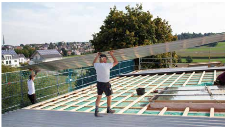
Wegen störender Geräuschentwicklung im Innenraum mussten die Aluminiumwellen abgedeckt werden.
