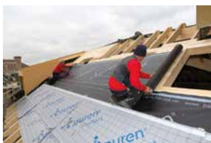
Vollflächige Luftdichtung.
