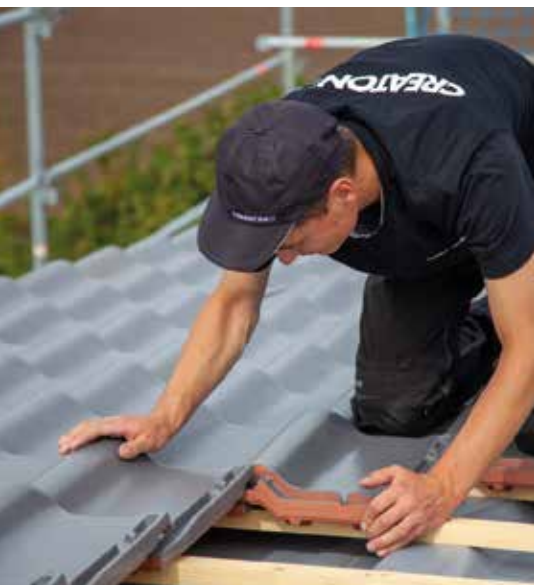
Nach Montage der Traglattung konnte mit der finalen Arbeit – der Verlegung der Dachziegel – begonnen werden.
