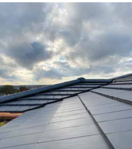
Ergoldsbacher Level RS® – ein Glattziegel für flach geneigte Dächer ab 10°
