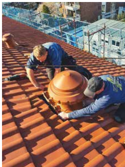
▲ Durch die individuelle Anpassung an den vorhandenen Dachziegeltyp und die Farbe schmiegt sich der Wrasenlüfter von FLECK – hier in Nennweite DN 400 – optisch perfekt in das Gesamtbild ein.
