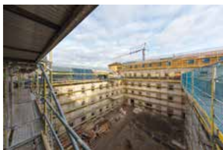
Blick in den Innenhof des Ludwigscarrées.
