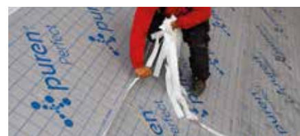
Verlegung der Steildachdämmung.
